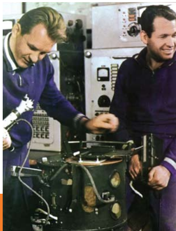
В.М. Кубасов і Г.С. Шонін поряд з установкою для зварювання в космосі «Вулкан», 1968 р.
