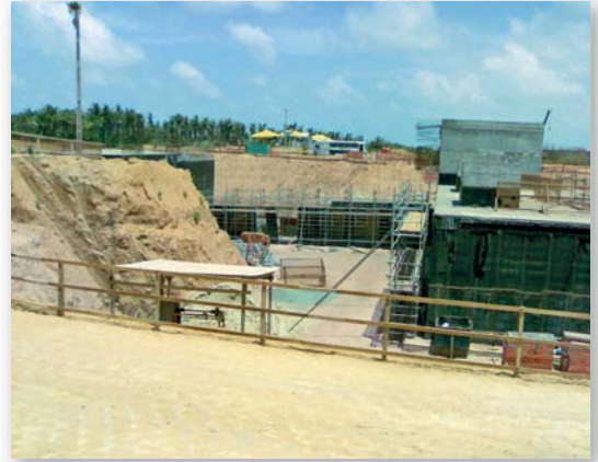
Роботи із закладання фундаменту будівлі систем заправлення КРП
