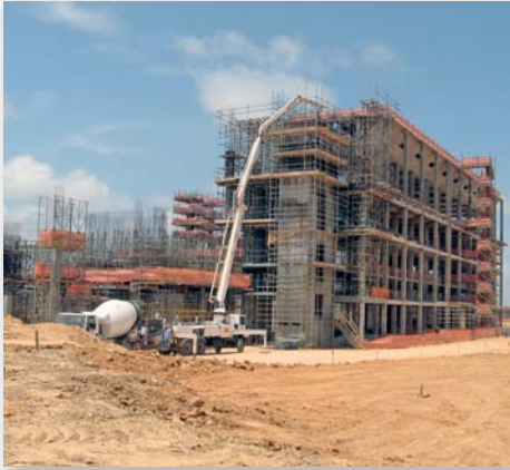
Будівництво МВК КА та головного блоку на космодромі Алкантара
