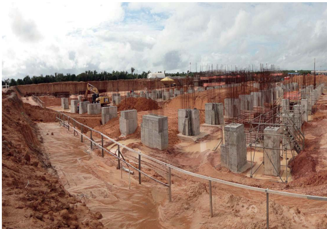
Будівництво об'єктів наземного комплексу на космодромі Алконтара
