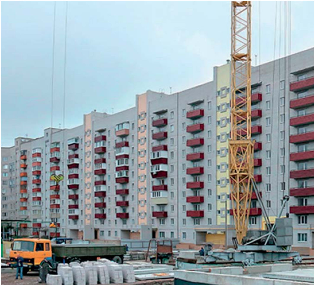
Будівництво нового будинку для працівників КБ «Південне» на житловому масиві Червоний Камінь
