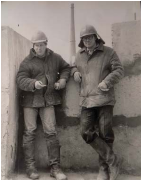
Олександр Дегтярев і Георгій Дрозденко на будівництві житлового будинку, кінець 1980-х рр.
