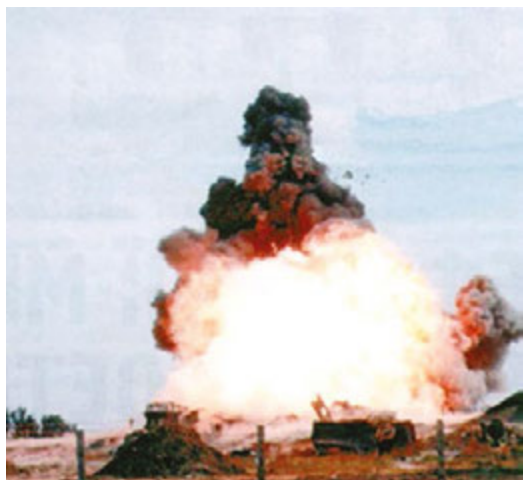
Ликвидация шахтно-пусковой установки методом подрыва
