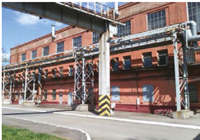
Монтажный корпус базы огневых испытаний
