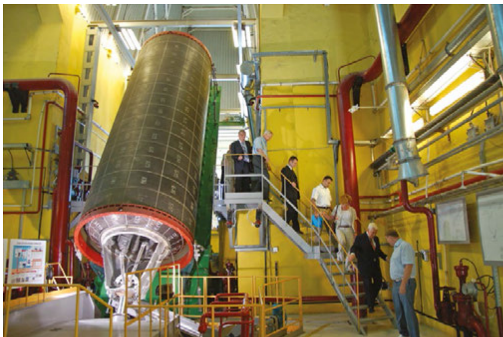
Пилотная установка на Павлоградском химическом заводе по извлечению твердого ракетного топлива из корпусов двигателей МБР РС-22 (SS-24), которые находились на боевом дежурстве на территории Украины и были демонтированы согласно Договору СНВ-2, август 2012 года
