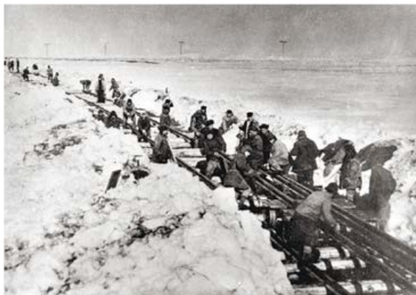
Строительство Северо-Печорской железной дороги
