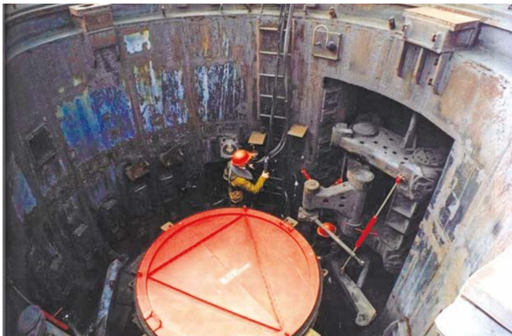
Выполнение работ по обслуживанию МБР в шахте
