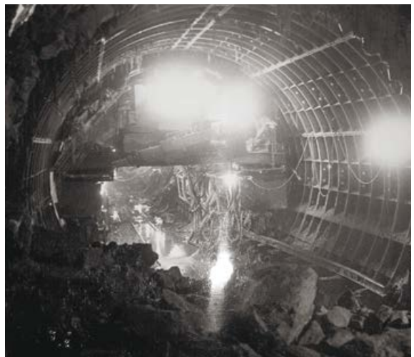
Строительство перегонных тоннелей метро первой очереди. Наглядно видна днепропетровская гранитная геология
