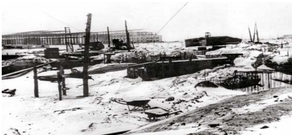
Строительство автозавода в Днепропетровске
