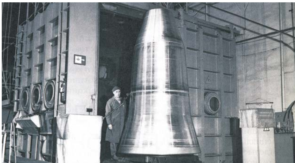
Установка электронно-лучевой сварки УЛ-110
