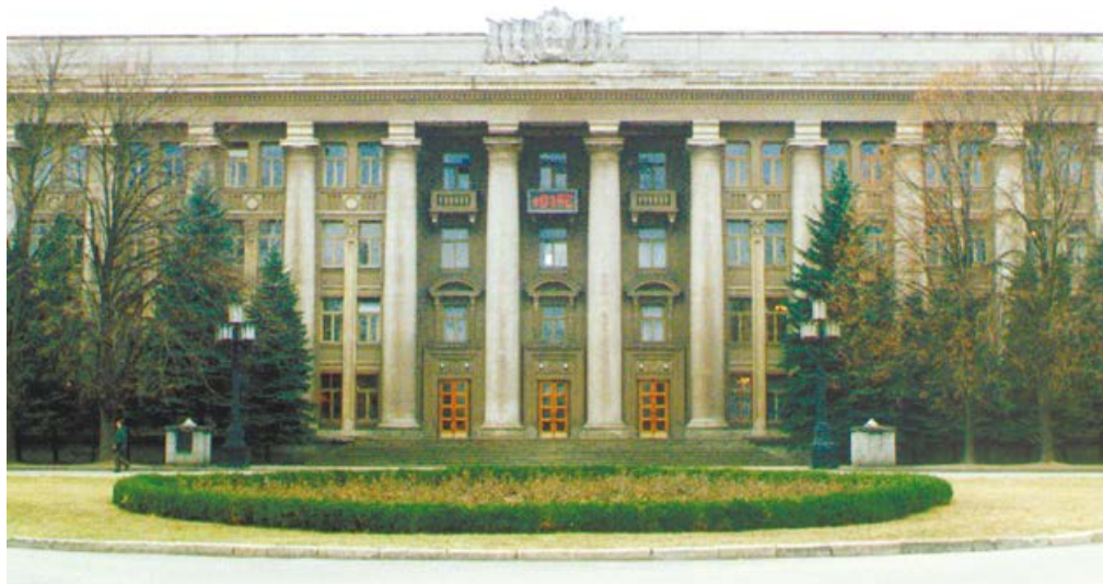
Административный корпус (заводоуправление) Южмаша
