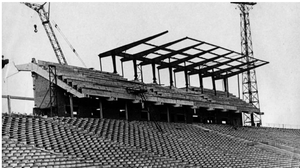
Стадион «Метеор». Начало строительства
