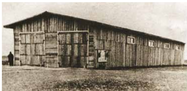
Временный монтажно-испытательный корпус
