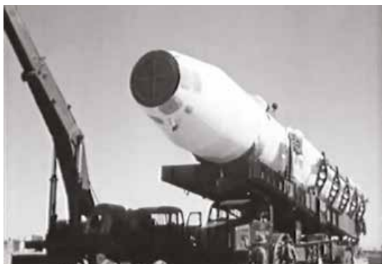
Начало установки ракеты Р-16 на стартовый стол
