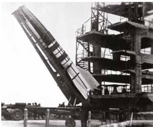
Установка ракеты Р-1 на стенд для огневых испытаний, полигон Капустин Яр
