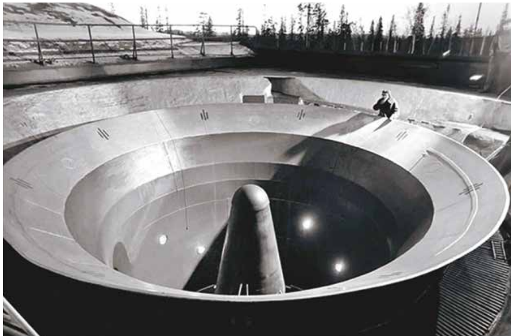
Ракета Р-14 в шахтной пусковой установке
