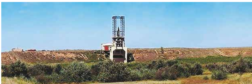
Стенд для огневых испытаний ракет Фау-2 на полигоне Капустин Яр
